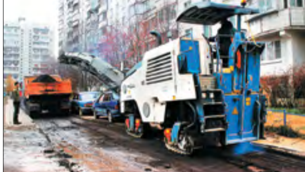
Ремонт дороги на ул. Текстильная, 12
